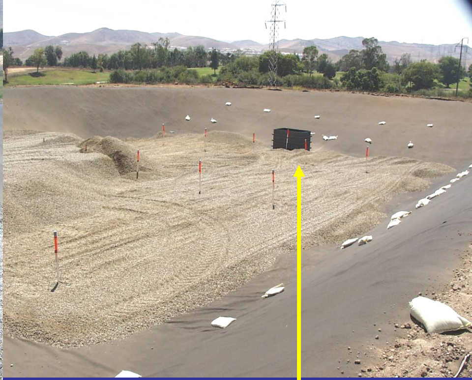
Effluent collection box
